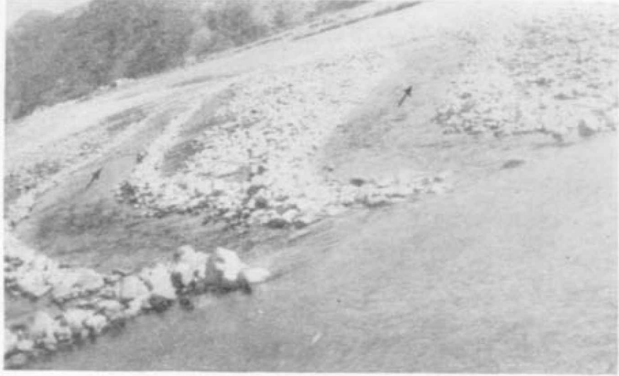
图 8 在漫滩上人工建造的产卵洪道
